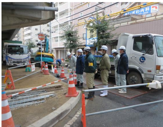
安全対策等の確認
