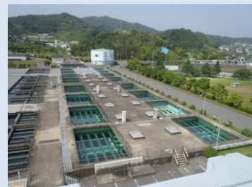
牛頸浄水場急速ろ過池
