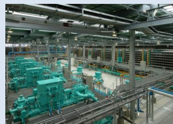
海水淡水化センター施設内部
