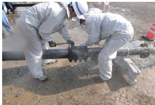
応急復旧訓練（配水管の修繕）
