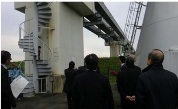
思案橋水管橋の現状を視察する委員
