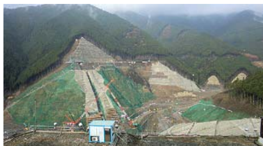
建設中の小石原川ダム
