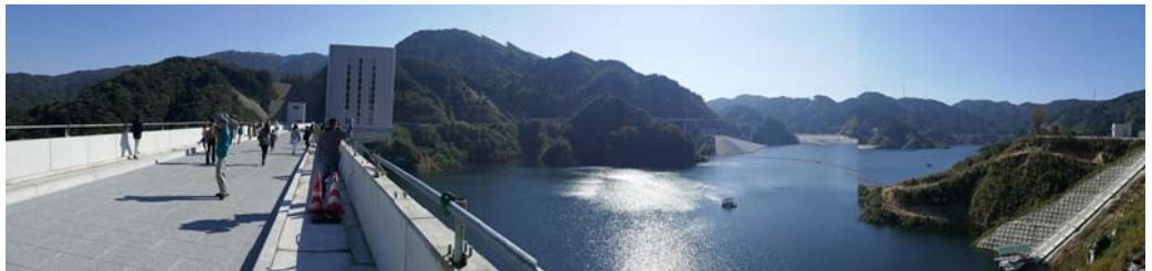
五ヶ山ダムの見学
