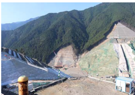
建設中の小石原川ダム
