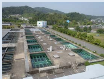
牛頸浄水場急速ろ過池
