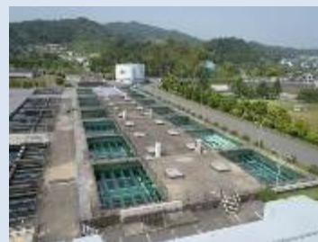
牛頸浄水場急速ろ過池
