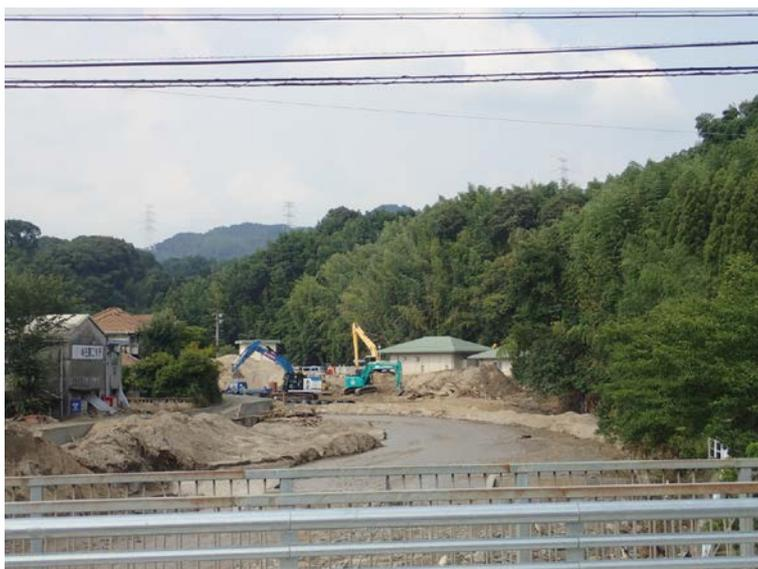
写真1 赤谷川の堆積土砂撤去工事
