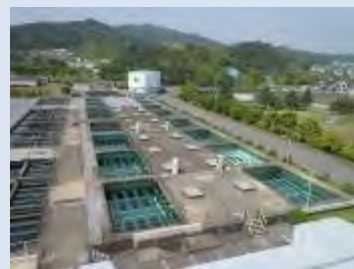
牛頸浄水場急速ろ過池
