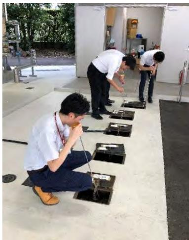
音聴棒による漏水調査
