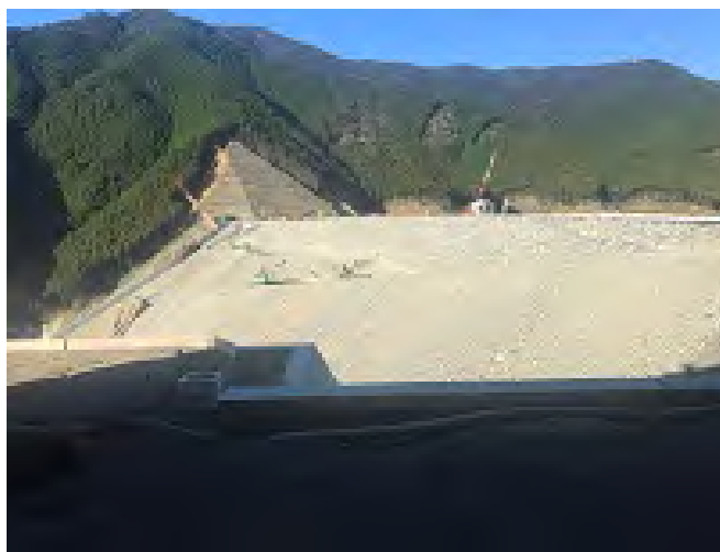
小石原川ダムの堤体
