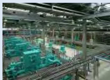
海水淡水化センター施設内部
