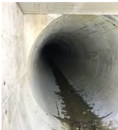
導水施設の導水管
