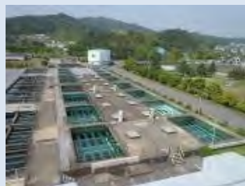
牛頸浄水場急速ろ過池
