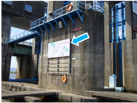
筑後大堰の閘門部分
