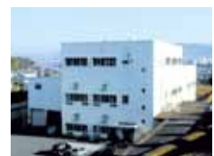
⑨沈でん物処理棟
