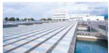
④沈でん池
