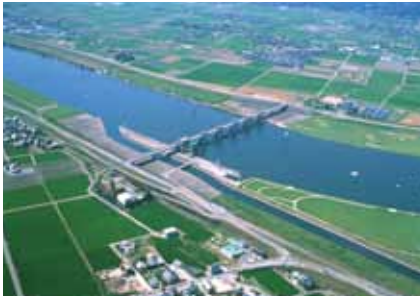
筑後大堰(久留米市)
