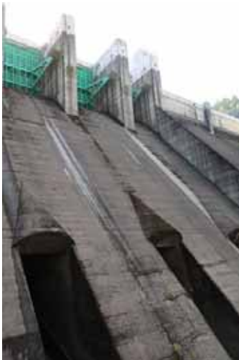
ダム堤体（下流側から）
