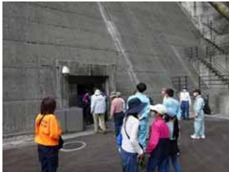
大山ダム監査廊入口
