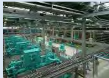
海水淡水化センター施設内部
