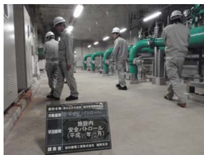
地下管廊点検の様子
