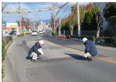
送水管布設中の仮舗装の 段差確認の様子
