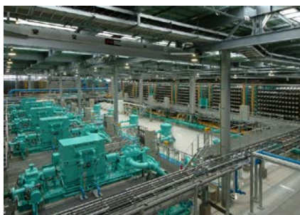
高圧ROポンプとUF膜ユニット
