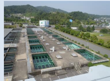
牛頸浄水場急速ろ過池
