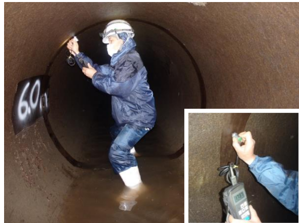
管板厚調査の様子
