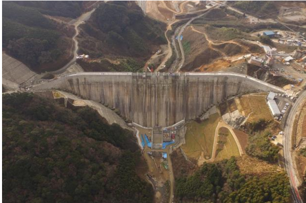
下流から上流を望む（平成27年12月末時点） 【堤体の横幅：556.0m、堤体の高さ：102.5m】
