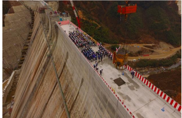
最終打設の状況（平成28年1月13日）
