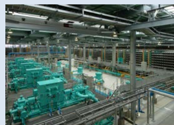
海水淡水化センター施設内部
