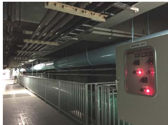
パトロールした浄水場の地下管廊(通路)
