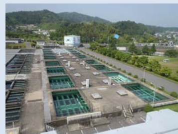
牛頸浄水場急速ろ過池
