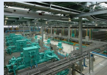
海水淡水化センター施設内部
