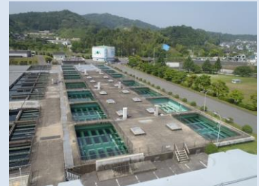
牛頸浄水場急速ろ過池
