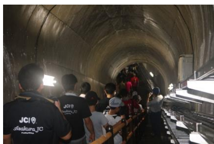
監査廊の見学
