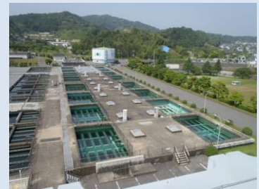
牛頸浄水場急速ろ過池
