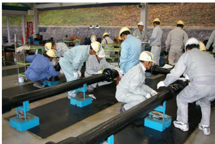
図－53 福岡市水道技術研修所における配水管工技能講習会のようす
