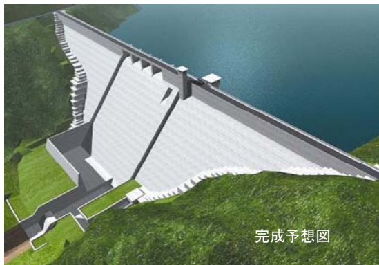
大山ダム(建設中)
