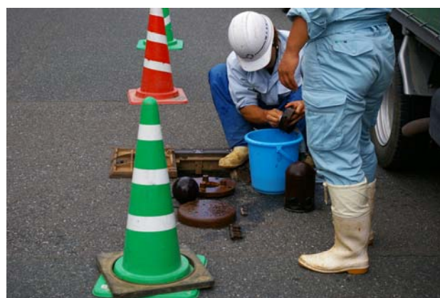
図－39 空気弁の分解・清掃状況
