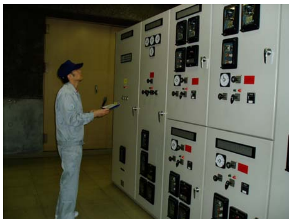
図-34 機器点検状況(牛頸浄水場)
