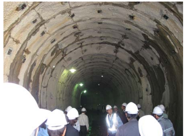
図-24 構成団体との工事進捗状況視察 (大山ダム仮排水トンネル)
