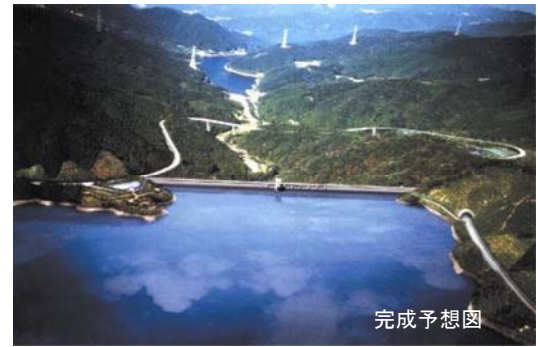
五ヶ山ダム(建設中)
