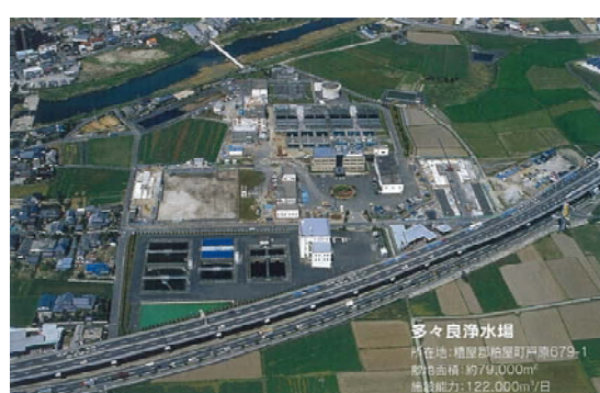
多々良浄水場
