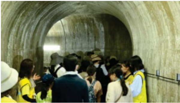
寺内ダム監査廊の見学
