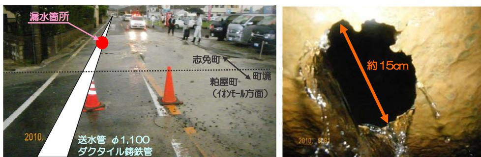
図3 下原系送水管幹線腐食漏水事故 (志免地区 φ1100 mm)
