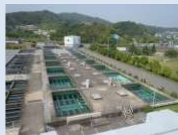
牛頸浄水場急速ろ過池
