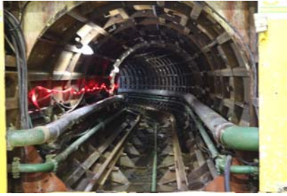
送水管用トンネル (口径約2m)
