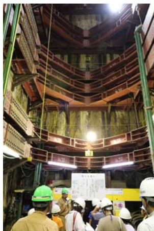
地下20mの工事現場
