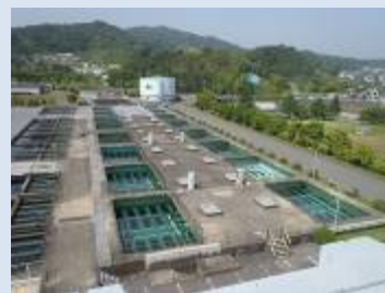
牛頸浄水場急速ろ過池
