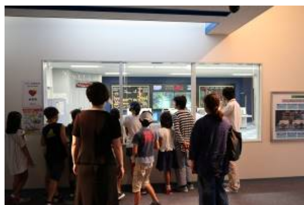
海水淡水化センターの中央監視室
