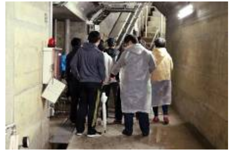
ダム監査廊の見学
