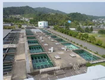
牛頸浄水場急速ろ過池
