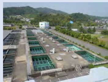
牛頸浄水場急速ろ過池
