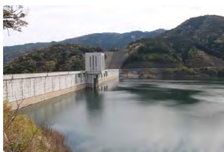
試験湛水中の五ヶ山ダム
