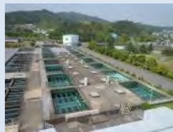
牛頸浄水場急速ろ過池
