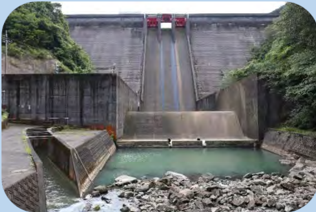
※余水吐ゲート試運転中
