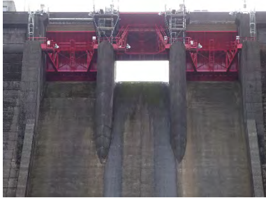
余水吐ゲート（※試運転中）
