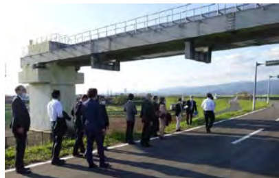
思案橋水管橋の視察
