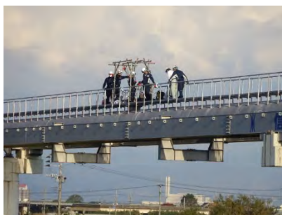
思案橋水管橋の管内調査
