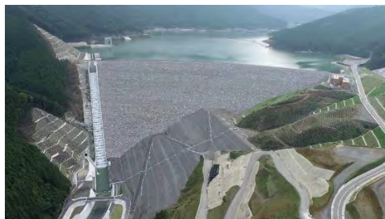
小石原川ダム（独立行政法人水資源機構提供）
