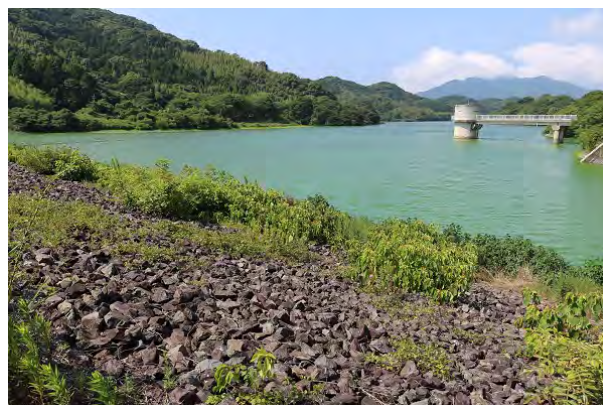
多礼ダム（右上が取水塔）
