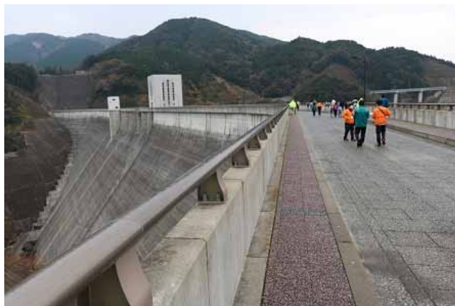
五ヶ山ダム堤体からの見学
