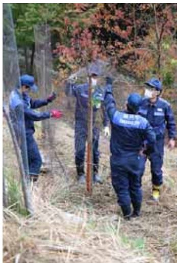
鹿ネットの設置
