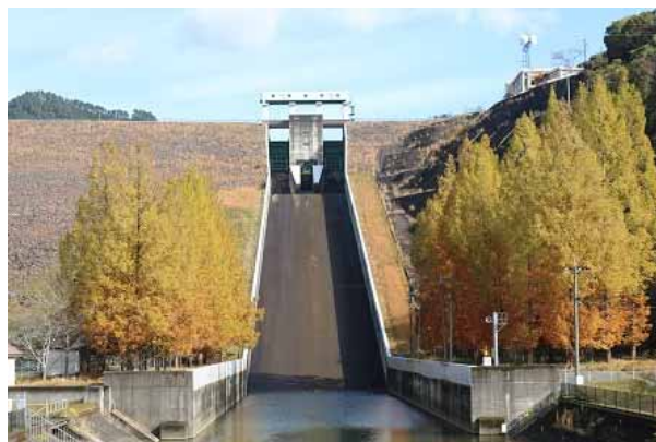
寺内ダム（放水路両側の黄色に色づいたメタセコイアが美しい）
