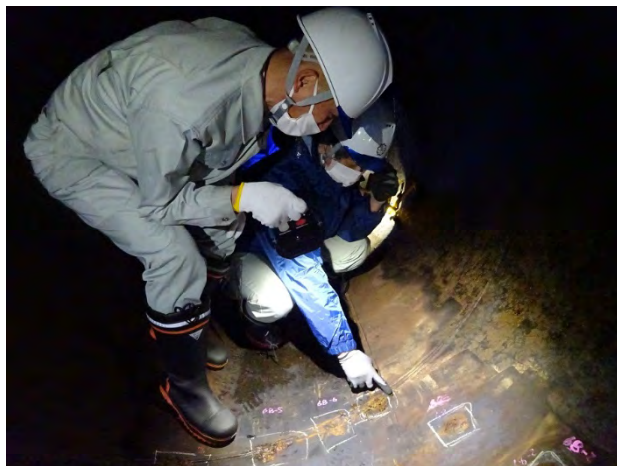
管内補修作業箇所視察の様子
