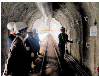
浅間・風越東部併設水路工事現場
