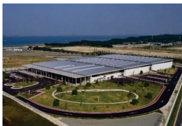
海水淡水化センター
