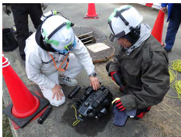
水中ドローンによる管内調査
