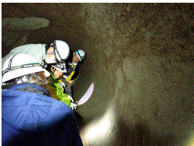
導水管内をくまなく点検中
