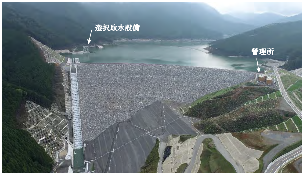
小石原川ダム全景（下流側から）
