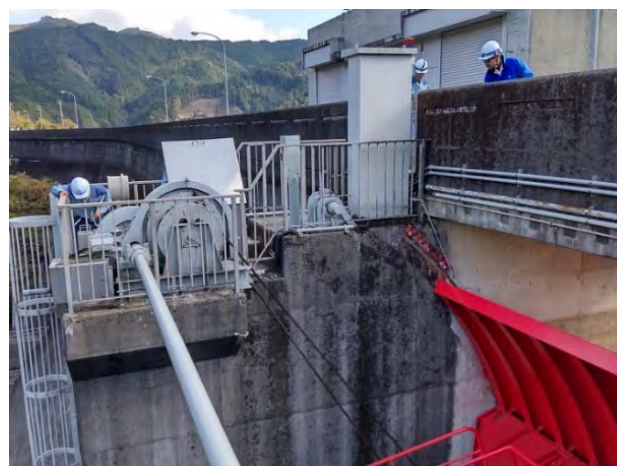
余水吐ゲート点検の様子(江川ダム)
