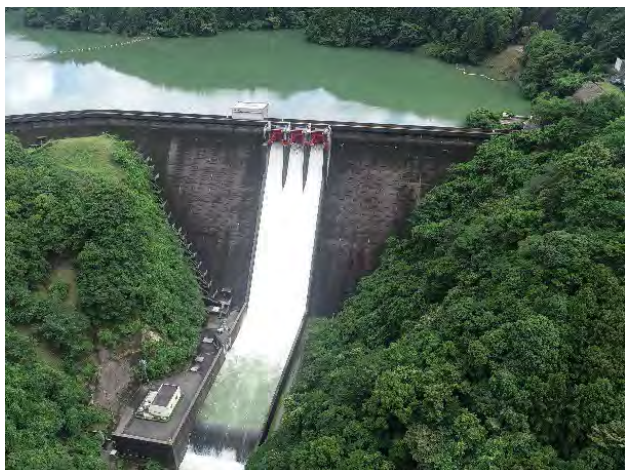
余水吐ゲートからの放流の様子(江川ダム)
