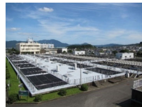
牛頸浄水場 ろ過池
