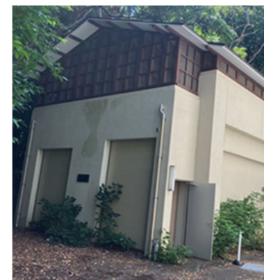
大隈ポンプ場
