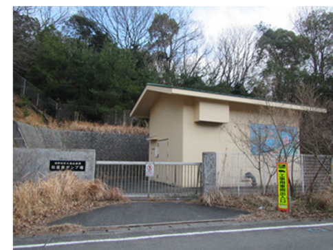
粕屋南ポンプ場
