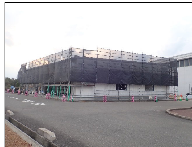
建設状況（令和7年1月）
