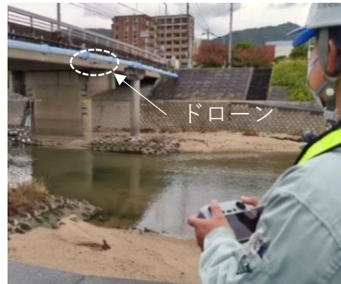
ドローンでの点検
