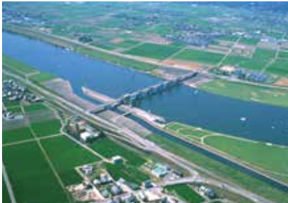
筑後大堰(久留米市)
