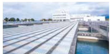
④沈でん池
