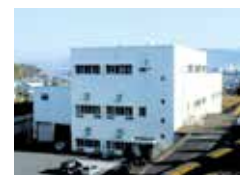
⑨沈でん物処理棟
