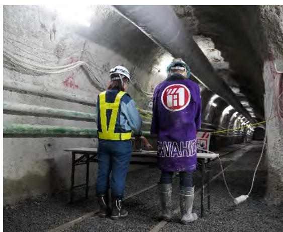
貫通に向けた発破点火状況
