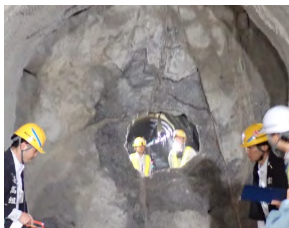
貫通状況（下口工区側より撮影）
