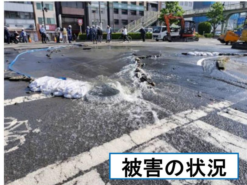
水道管の老朽化による破損（京都市）
