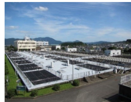
牛頸浄水場 ろ過池
