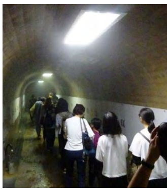
監査廊の見学(鳴淵ダム)
