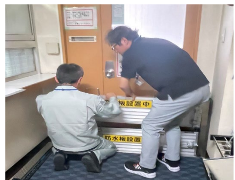
止水板の設置
