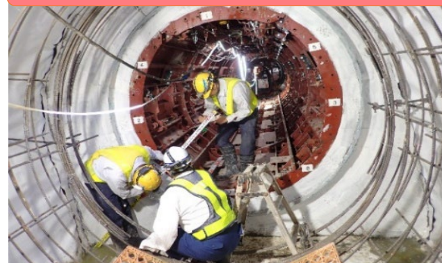
2号トンネル 覆工状況
