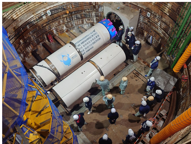
管路の耐震化工事 合同視察 (筑後川3企業団※)
