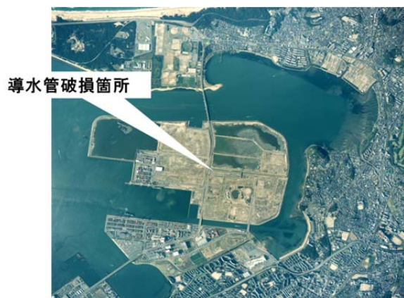
企業団導水管の被災箇所
