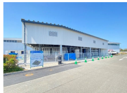
発電施設全景
