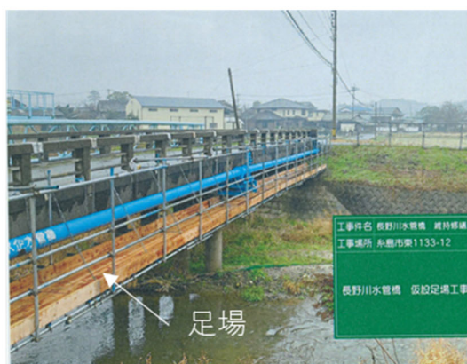
従来の点検 (足場の設置が必要)
