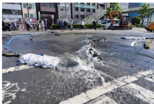
写真-10 老朽化による管の破損に 伴う漏水（京都市）
