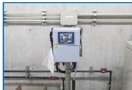
写真-7 水質監視装置の増設（牛頸浄水場）
