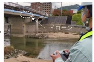
写真-11 水管橋の点検状況
