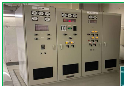
写真-6 電気設備の更新工事（牛頸浄水場）
