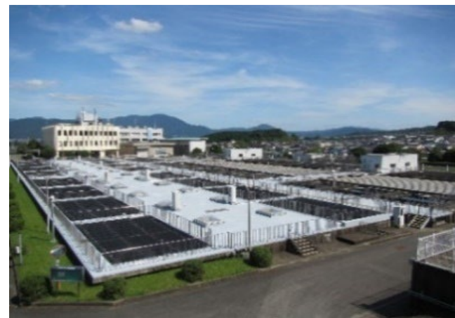
牛頸浄水場 ろ過池
