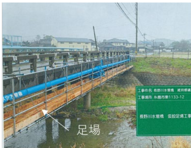
従来の点検 (足場の設置が必要)
