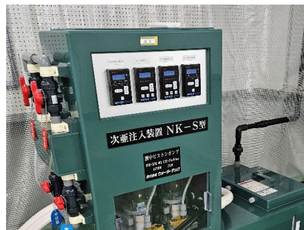
追塩設備（塩素を追加注入する設備）
